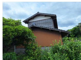
附属家:木造瓦葺2階建(109.97㎡)
