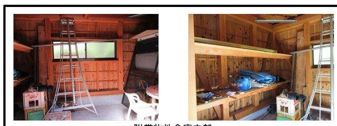
附帯物件倉庫内部
