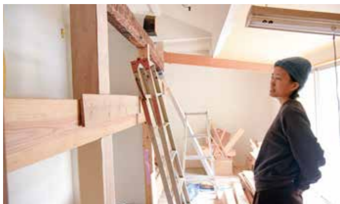
▲現在、自宅をゲストハウスに改造中。大きな工事は業者をお願いし、ベッドスペースやパンを焼く施設などをDIYで制作している
